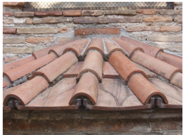
Dach mit tegulae und imbrices in San Vitale, Ravenna (I)
